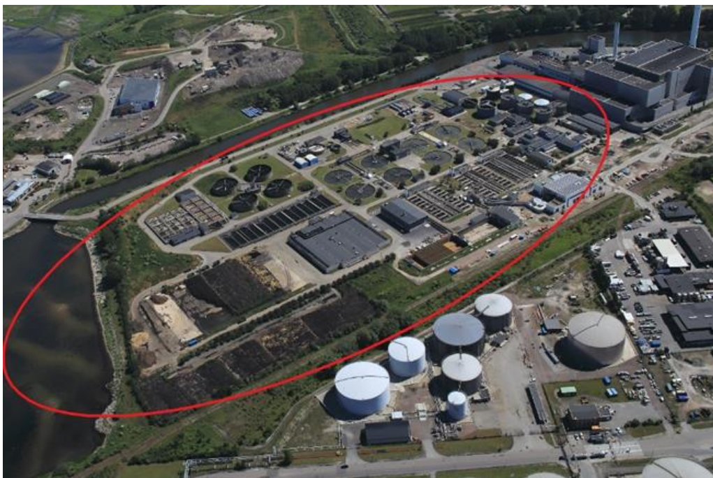
Figur 13-1 Vy över Sjölanda avloppsreningsverk och omgivning.
