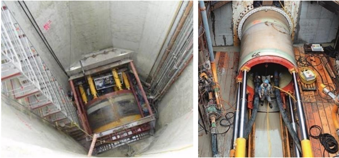
Figur 8-12 Bilder över en Jacking-station. Källa: Projekt H3-4 Emschertunneln.
