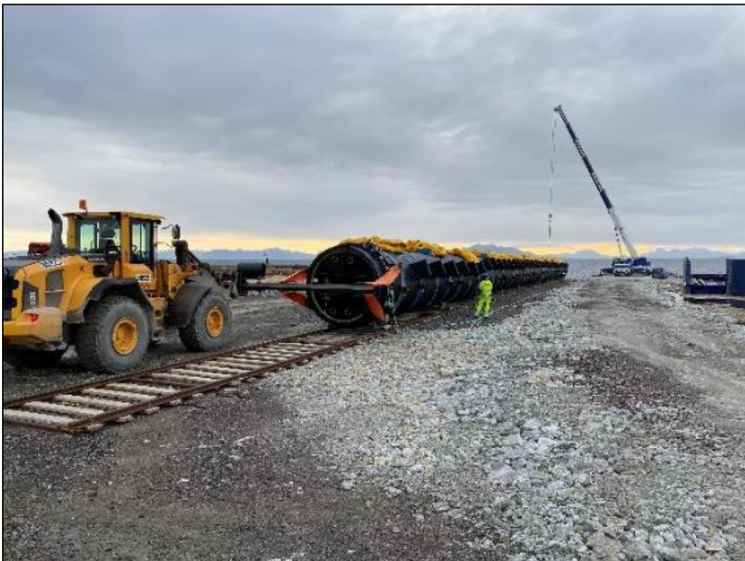
Figur 8-9. Sjösättning av PE-profilrör (bild tagen av Sweco 2022).
