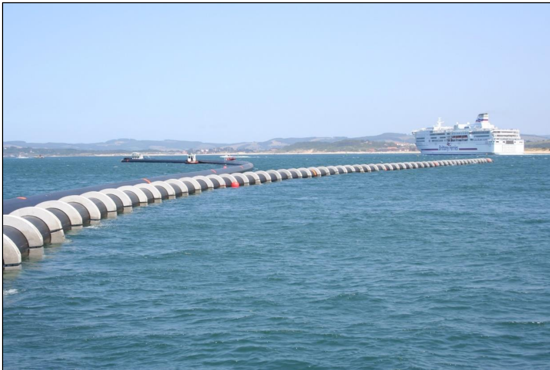
Figur 8-3. Exempel på en viktad och en oviktad tryckledning som ligger flytande inför transport till viktning och sänkingsplats (Bild tagen av Sweco).
