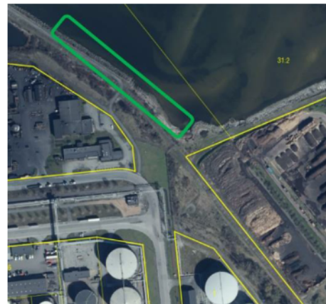
Bild 4: Strandkant som kan användas för vattenförsörjning av släckutrustning vid brand i oljehamnen.
